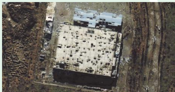
Ryc. 3. Zniszczenia hangaru lotniska w Doniecku (źródło: DigitalGlobe, dostarczone przez European Space Imaging)
